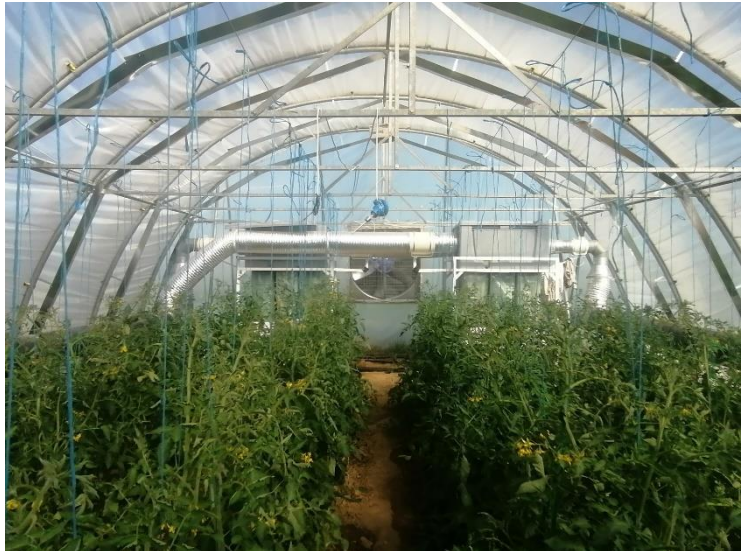
Rys. 1. System klimatyzacji z ciekłym osuszaczem powietrza zainstalowany w tunezyjskim demonstratorze TheGreefa.
