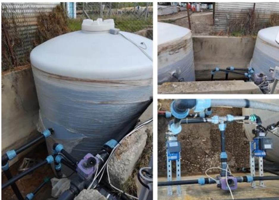
Figura 34. Pompe ed elettrovalvole installate a lato dell'accumulo TCF.
