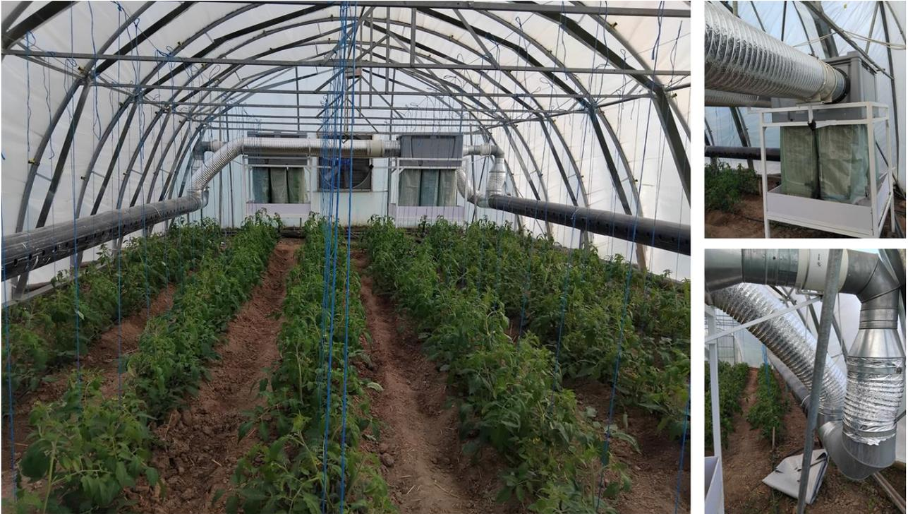
Figura 35. Installazione dei dispositivi assorbitori e del sistema di circolazione dell'aria all'interno della serra (ventilatori e condotti dell'aria).
