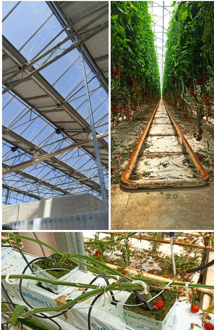
Figura 54. La serra di Sfera Agricola – sistema tetto (in alto a sinistra), sistema di riscaldamento a tubazioni (in alto a destra) e le piante di pomodoro con sensori (in basso).
