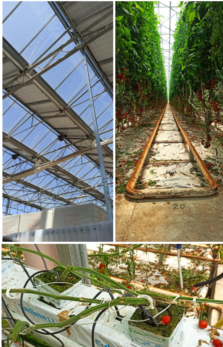
Figure 54. La serre de Sfera Agricola - système de toiture (en haut à gauche), chauffage par tuyauterie (en haut à droite) et les plants de tomates avec capteurs (en bas).
