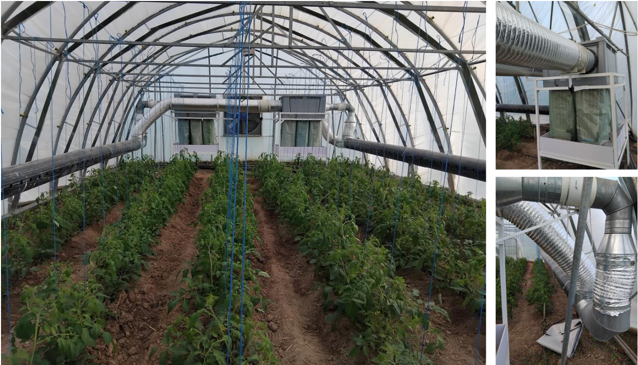
Figure 35. Installation des unités d'absorption et du système de circulation d'air dans la serre (ventilateurs + gaines d'air).
