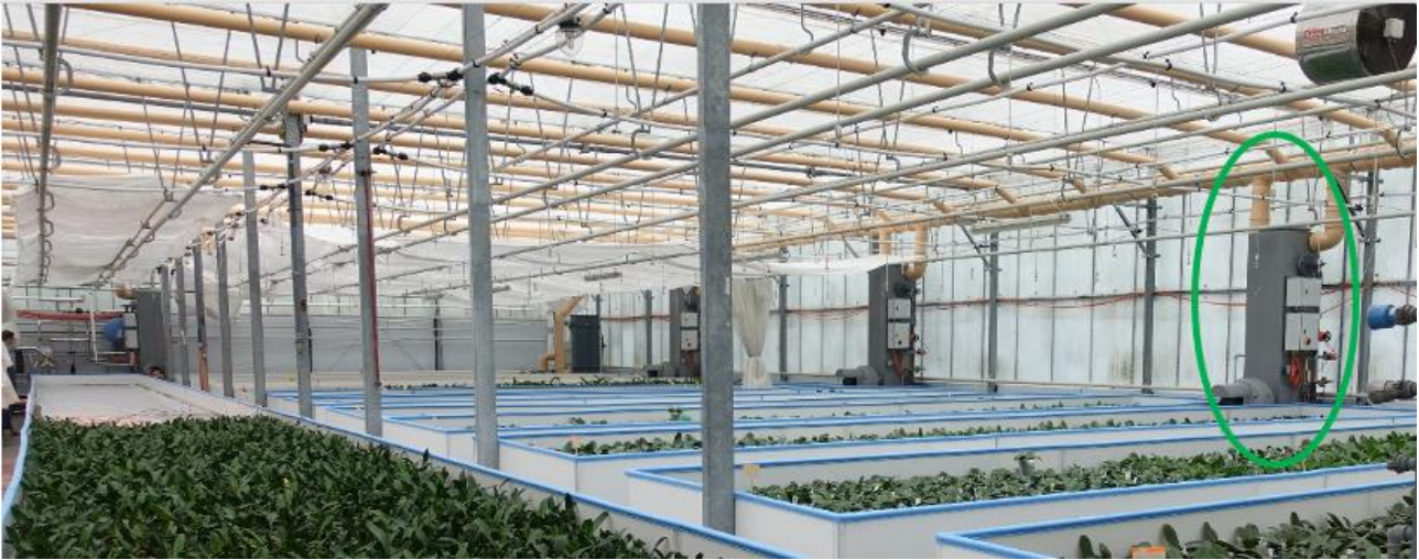
Figure 13. Tables de plantation dans le démonstrateur suisse. L'absorbeur est indiqué en vert.
