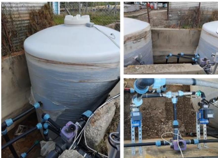
Rys. 34. Pompy i elektrozwory.
