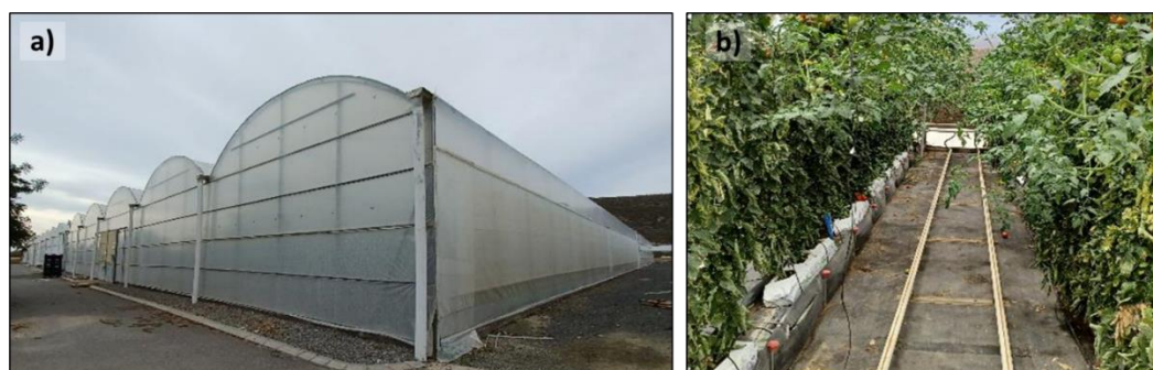
Figura 46. Invernadero multitúnel sin calefacción (a) y cultivo de tomate en el interior (b) en la Estación Experimental UAL-ANECOOP en Almería (España).
