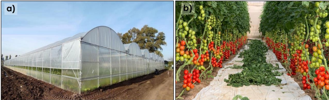
Figura 48. Invernadero comercial multitúnel sin calefacción (a) y cultivo de tomate en el interior (b) en Italia (COSER. 2024; De Marinis, 2023).
