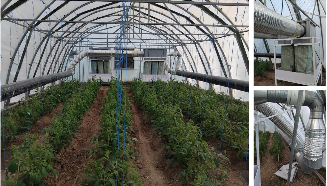
Figura 35. Instalación de los dispositivos absorbentes y del sistema de circulación de aire dentro del invernadero (ventiladores + conductos de aire).
