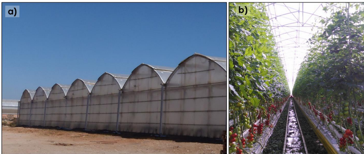
Figura 47. Invernadero comercial multitúnel calefactado con doble cubierta (a) y cultivo de tomate en el interior (b) de la empresa Natural Growers en Almería.
