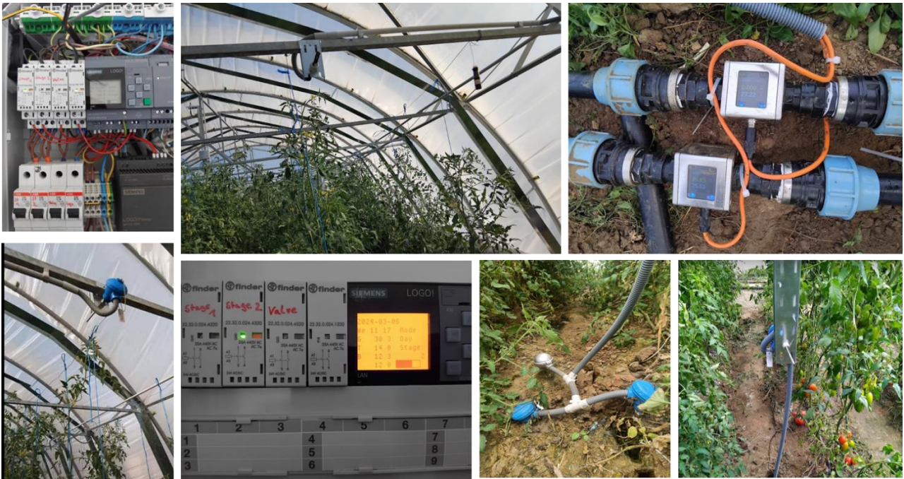
Figura 36. Instalación de la caja de control, los sensores y el sistema de recogida de datos.
