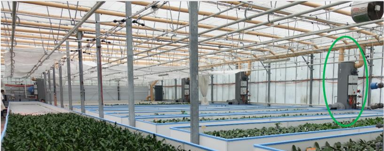
Figura 13. Mesas de plantación en el demostrador suizo. El absorbedor está marcado en verde.
