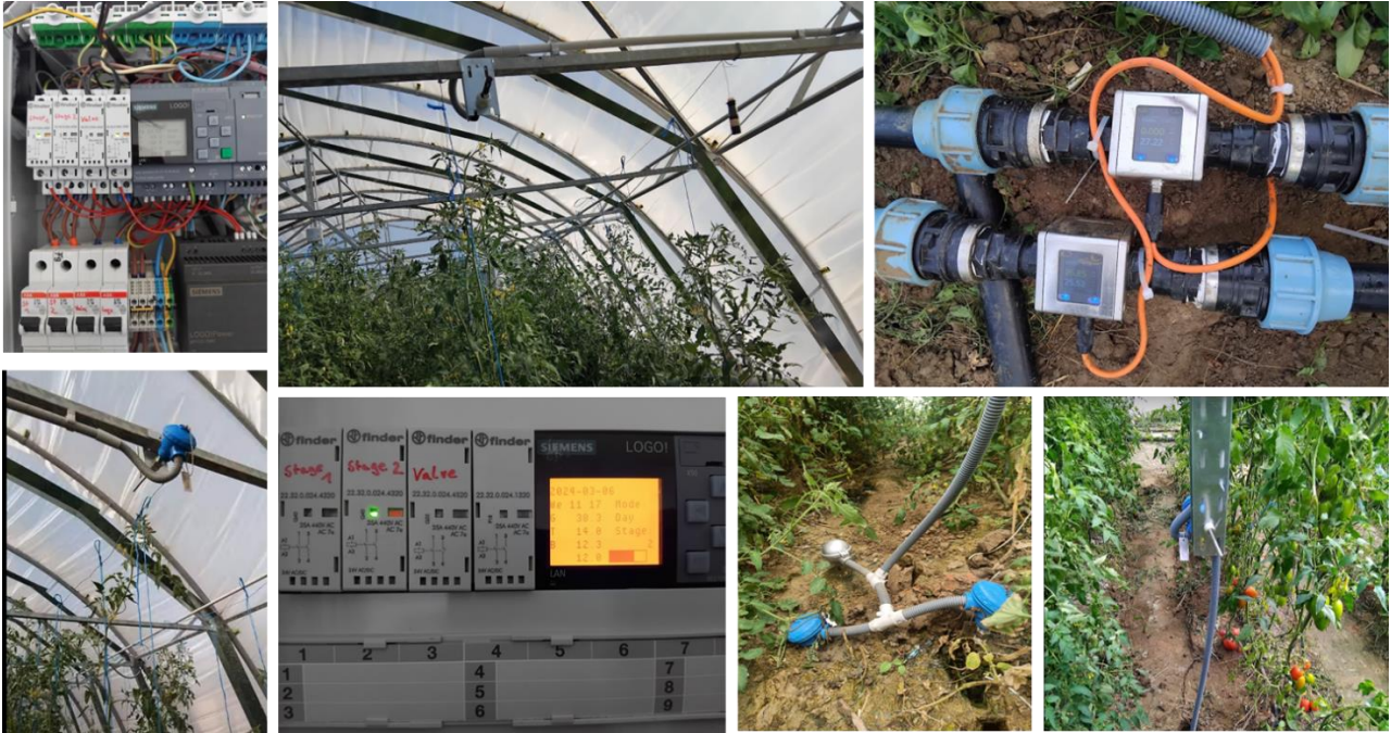
Rys. 36. Instalacja skrzynki kontrolnej, czujników i systemu gromadzenia danych.
